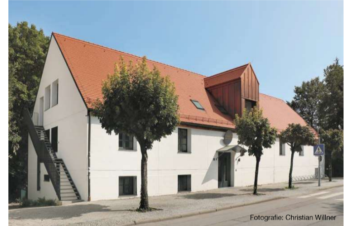
Generalsanierung Pfarrheim St. Kastulus in Moosburg Standort: Leinenbergerstr. 10, Moosburg Architektur: heinz pflügler partner architekten
