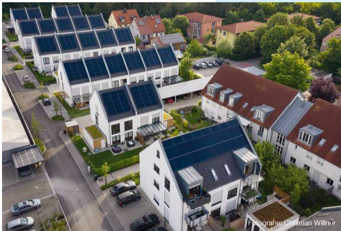
Sonnensiedlung CitrinSolar in Moosburg Standort: Sonnensiedlung Moosburg Architektur: heinz pflügler partner architekten
