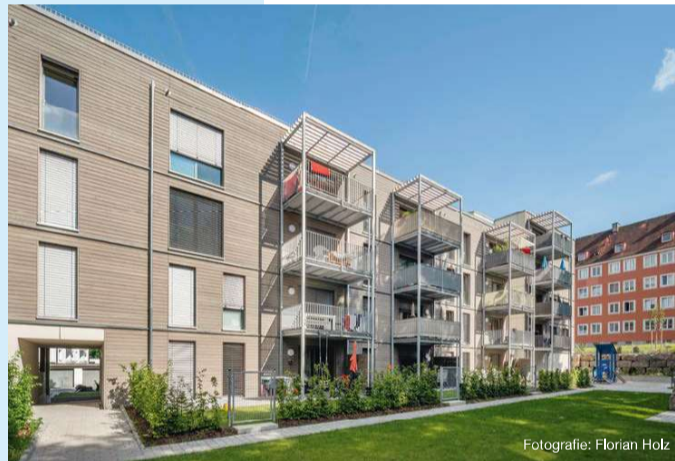
35 geförderte Wohnungen mit TG in Hybridbauweise Standort: General-von-Stein-Str. 16-18, Freising Architektur: A2freising architekten
