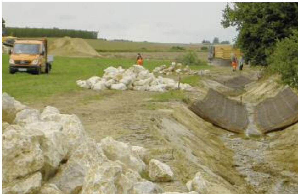
Renaturierung des Hutgrabens in Wolfersdorf
