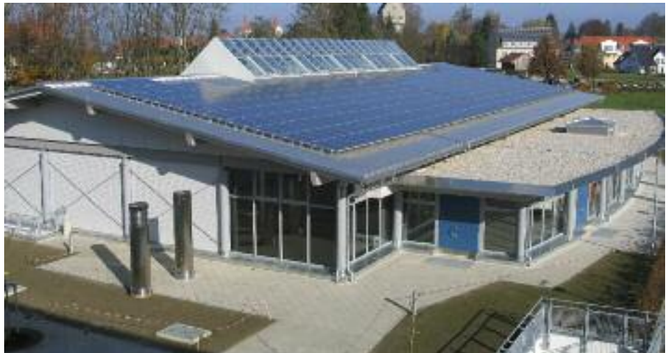
Solaranlage auf der Turnhalle der Kastulus-Realschule Moosburg
