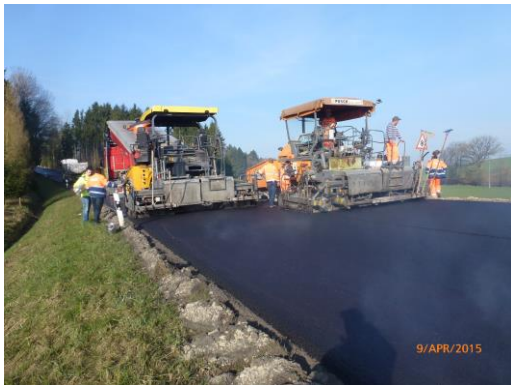
Einbau der Asphaltdeckschicht auf der FS 43
