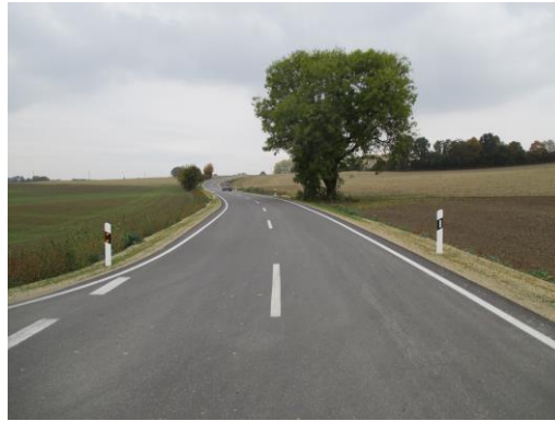
FS 28 nach dem Ausbau
