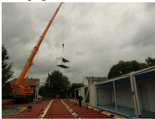
Aufstellung von Raumcontainern am Gymnasium Moosburg
