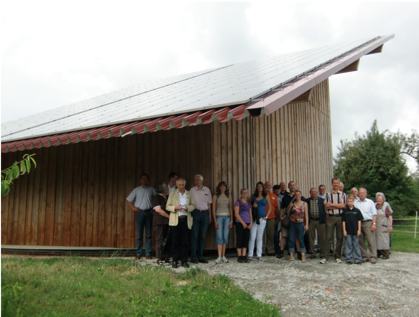
Gäste der Sommertour des Landrats vor der drehbaren Solarhalle in Rudelzhausen
