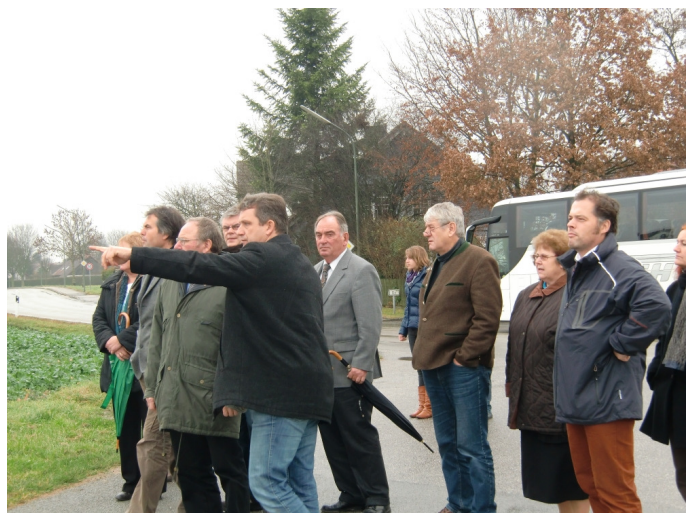
Tiefbauamtsleiter Konrad Huber erläutert den Mitgliedern des Kreisausschusses bei einer Kreisstraßenbereisung im Herbst den Verlauf der Westtangente Moosburg.
