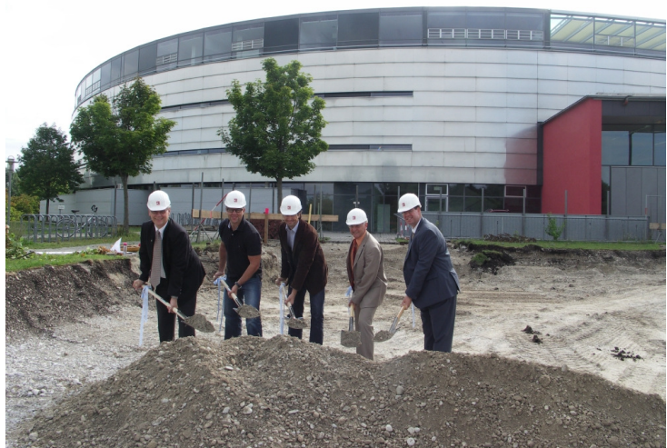
Spatenstich für den Erweiterungsbau am Oskar Maria Graf-Gymnasium in Neufahrn
