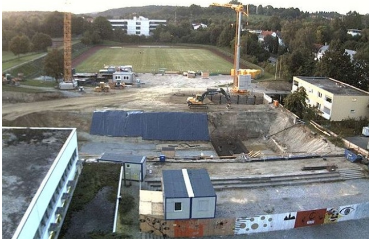
Baubeginn für den dritten Bauabschnitt am Camerloher-Gymnasium in Freising
