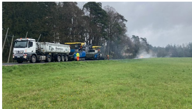
Zwischen Au und Haarbach erhielt die FS 39 eine neue Deckschicht.
