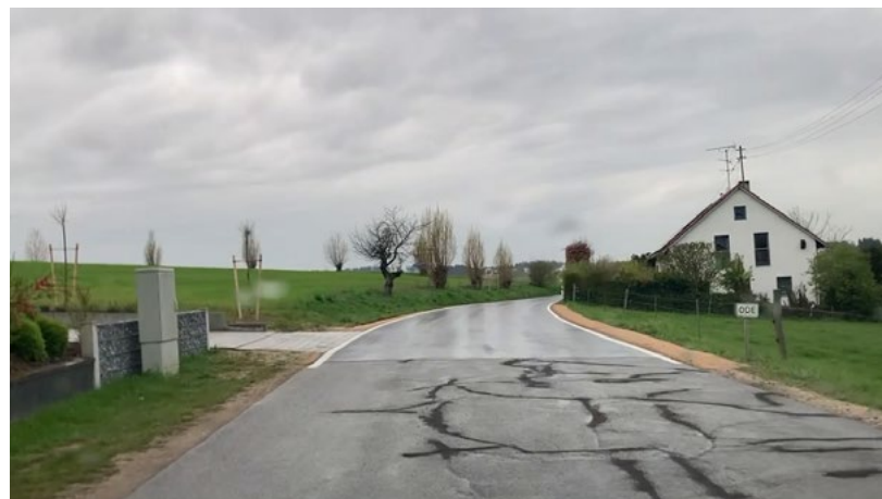
FS 28 Schlag bis Schweinersdorf: Das letzte Teilstück der FS 28 (Schweinersdorf - FS 32) wurde saniert.
