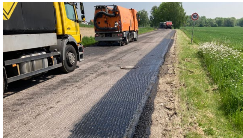
FS 6: Deckenbau auf einer Länge von ca. 700 Metern von Fahrenzhausen bis Jarzt
