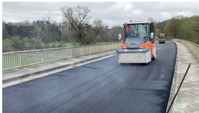
FS 13 Langenbach – Kreisverkehr bei Haag : Die Asphaltdecke wurde saniert, auch auf der Amperbrücke.
