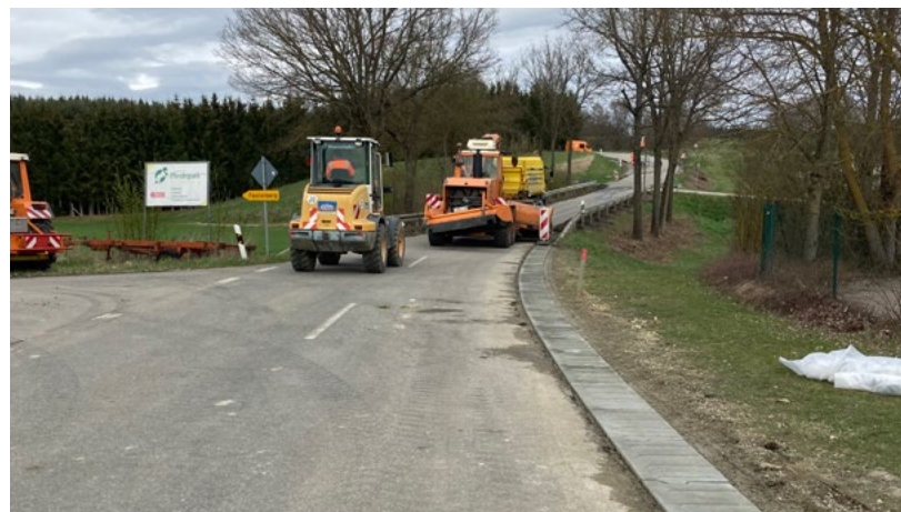
FS 25: Von Nandlstadt bis Hausmehring wurden Asphaltdeckschicht und Bankette erneuert.
