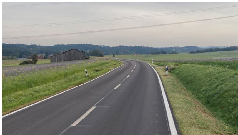
Die FS 22 zwischen Obermarchenbach und Gerlhausen wurde ertüchtigt.
