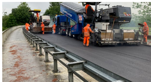
FS 9 Deckenbau Amperbrücke
