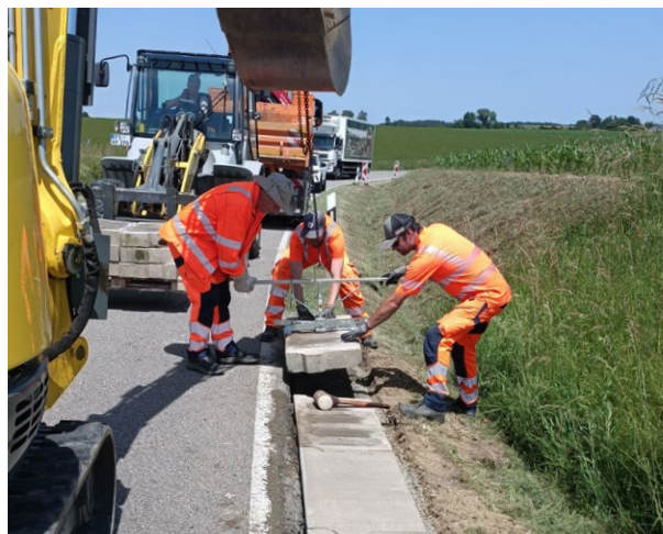
Mitarbeiter des Bauhofs beim Setzen von Bankettplatten.
