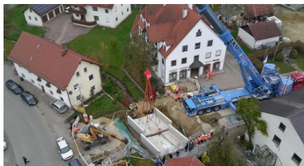
Mit einem Schwerlastkran wurden die großen Betonteile der neuen Brücke über den Haselreuther Graben in Hörkertshausen (FS 25) eingehoben.
