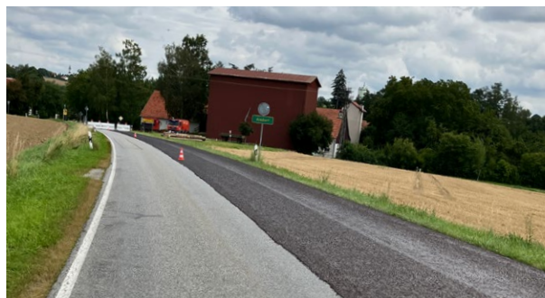
Zwischen Unterhaindlfing und der FS 27 erhielt die Kreisstraße FS 16 eine neue Deckschicht.
