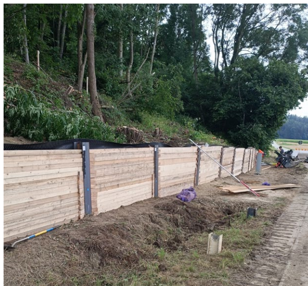
Eine provisorische Sicherung baute der Bauhof an der FS 33 ein, nachdem der Hang zwischen Kranzberg und Giesenbach abgerutscht war.
