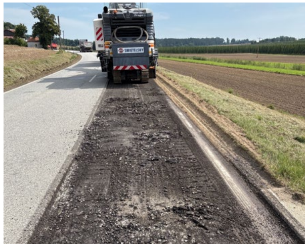
Eine Kalkhydratsuspension wurde auf die FS 32 aufgetragen.
