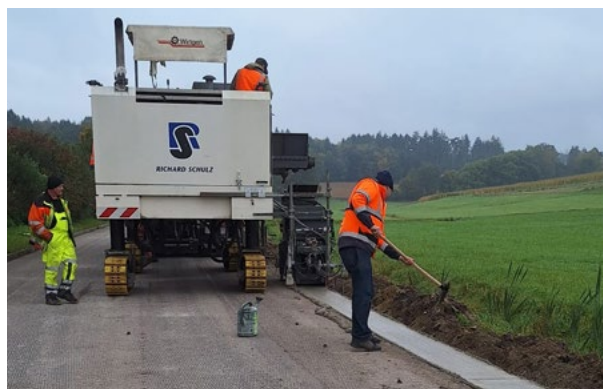
Die Fahrbahn der FS 30 hat die ausführende Firma um zwei Zentimeter abgefräst und neu erstellt.
