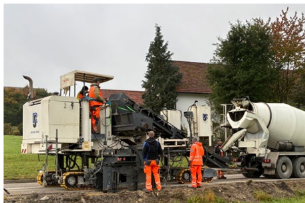
Erster Probelauf der neuen Technik: Offset-Gleitschalungsfertiger.
