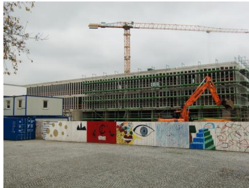
Richtfest für den Erweiterungsbau am Camerloher Gymnasium in Freising
