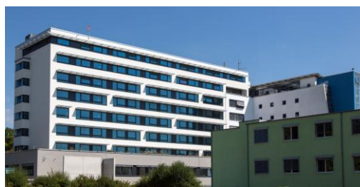
Im Frühjahr 2014 bezugsfertig: das neue Bettenhaus am Klinikum Freising
