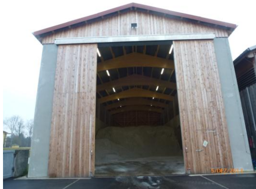
Die neue Salzhalle am Landkreisbauhof
