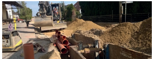
An der FS 16 wurden auch die Entsorgungsleitungen erneuert.
