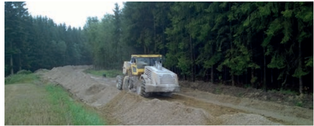
Verbesserung des Bodens durch den Einbau von Kalk an der FS 9.
