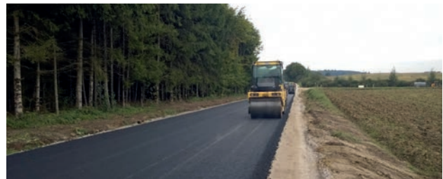
Einbau der Asphalttragschicht auf der freien Strecke der FS 9.
