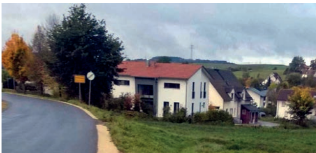
Einbau der Asphaltdeckschicht und Ertüchtigung der Bankette auf der FS 38.
