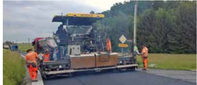
Einbau der Asphaltdeckschicht und Ertüchtigung der Bankette auf der FS 25
