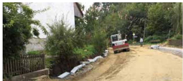
Herstellung der Randeinfassung an der FS 35
