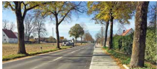
Erneuerter Fahr- und Gehweg der FS 12
