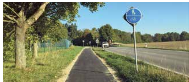
Sanierter Geh- und Radweg an der FS 9
