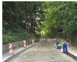
Ortsdurchfahrt Kranzberg: Abdichtung der Bodenplatte und der sanierte Abschnitt der Stützwand.
