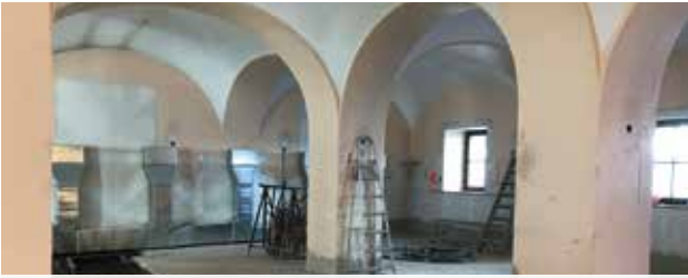
Der Gastraum nach der Entkernung, bevor die Bodenöffnungen verschlossen wurden
