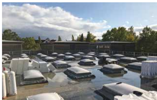
Erneuerung von 36 Lichtkuppeln
