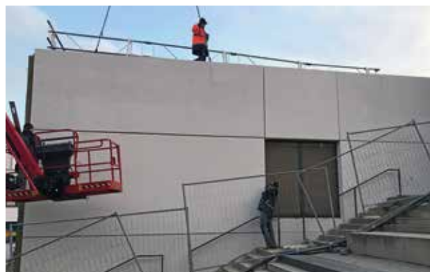
Neue Sichtbetonfertigteilfassade
