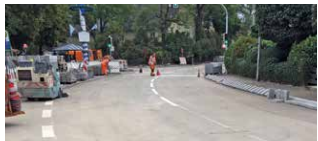
Teilabschnitt der FS 20 nach Fertigstellung und Markierung.
