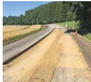
FS 33: Ausbau der Asphalttragschicht und der sanierte Streckenabschnitt.
