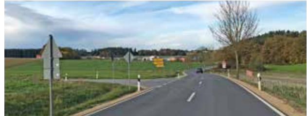
Die Strecke zwischen Gammelsdorf und der Landkreisgrenze bekam eine neue Deckschicht.
