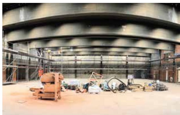
Die Turnhalle wurde vollständig entkernt.
