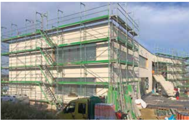
Fassaden- und Putzarbeiten
