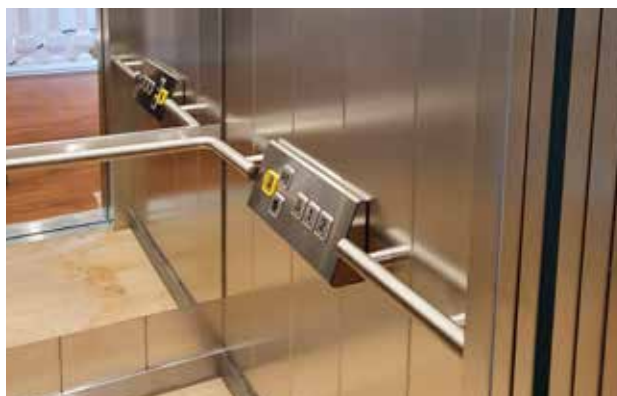
Erneuerung der Aufzüge
