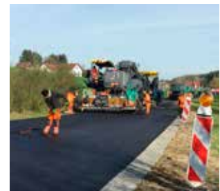
FS 22: Einbau der Asphaltdeckschicht auf der vorhandenen Asphalttragschicht
