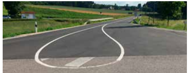
Beginn der Baumaßnahme an der FS 32: Die Markierung ist auf dem Bild noch nicht fertiggestellt
