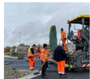
FS 32: Bild Links: Asphaltierung der neuen Querungshilfe Bild rechts: Asphaltierung Kreisverkehr
