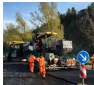
FS 22: Einbau der Asphaltdeckschicht auf der vorhandenen Asphalttragschicht
