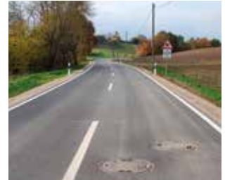
FS 34: Fertiggestellte Deckschicht mit neuer Markierung
