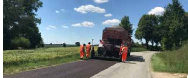
FS 16: Einbau der Deckschicht im Kalteinbau mit Ampelregelung
