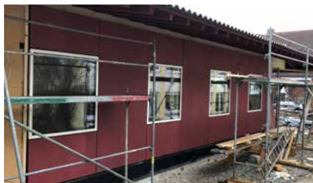
SFZ Moosburg – Am Sonderpädagogischen Förderzentrum, Außenstelle Moosburg, entsteht ein Interimsbau in Holzmodulbauweise.
