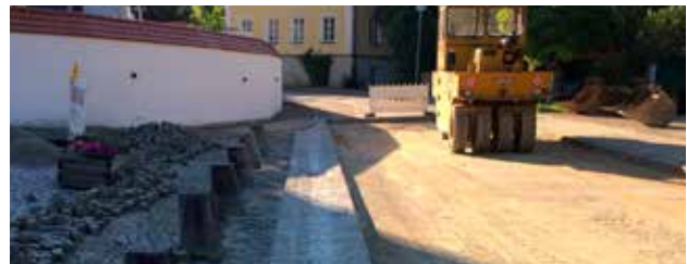
FS 25: Sichtbar ist die Kiestragschicht für Aufnahme der Asphaltsschichten im Bereich der ehemaligen Pflasterfläche.
