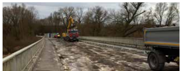
Brücke mit den neuen Kappen. Es fehlen hier noch die Schutzplanken auf dem Bauwerk.
