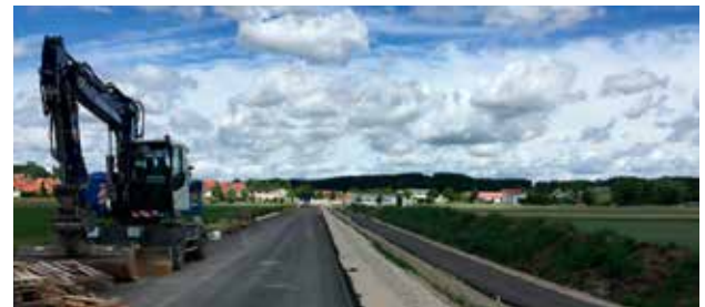
FS 8: Die Fahrbahndecke ist noch nicht aufgebracht.
