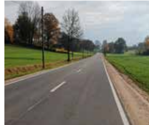
FS 34: Fertiggestellte Deckschicht mit neuer Markierung
