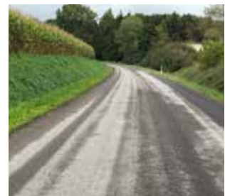
FS 10: Fräsfläche bis zur Erneuerung der Oberfläche
