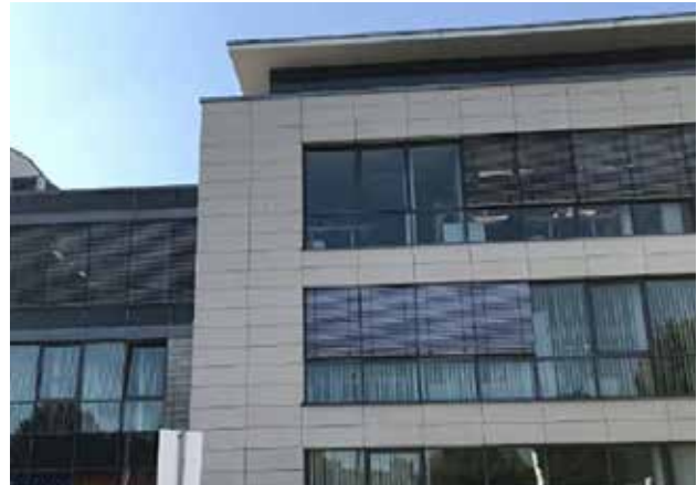
Neue Außenstelle für das Landratsamt an der Münchner Straße 4 (Südansicht Bürogebäude).
