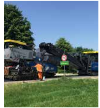
FS 28: Fertiggestellte Deckschicht mit neuer Markierung und Einbau der Deckschicht mit Spray-Jet.
