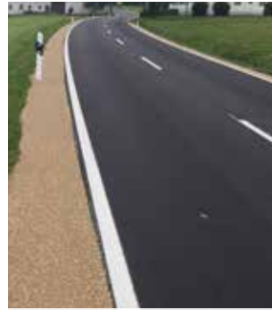
FS 28: Fertiggestellte Deckschicht mit neuer Markierung und Einbau der Deckschicht mit Spray-Jet.
