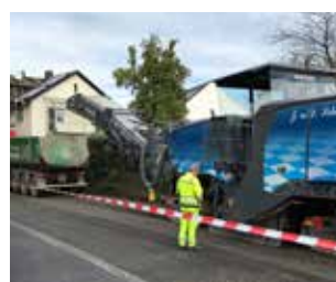
FS 16: Links wird der Bereich der OD gefräst und rechts der Kreuzungsbereich asphaltiert.
