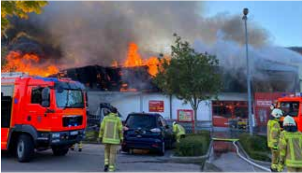
Der Großbrand eines Supermarktes in Allershausen beschäftigte zahlreiche Einsatzkräfte.
