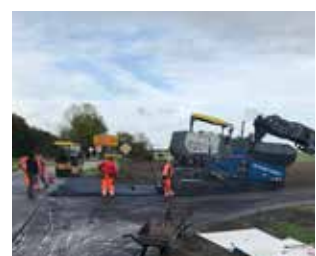
FS 16: Links wird der Bereich der OD gefräst und rechts der Kreuzungsbereich asphaltiert.
