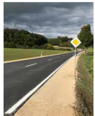
Rechts: Fertiggestellte Straße
