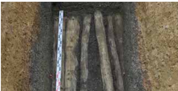
Teile des Holzbohlenweges im Bereich der Unteren Hauptstraße in Au i.d. Hallertau
