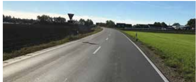
FS 6: Fertiggestellter Straßenabschnitt
