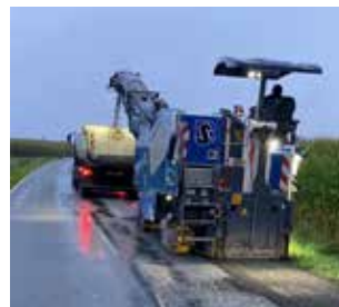
FS 10: Fräsfläche bis zur Erneuerung der Oberfläche
