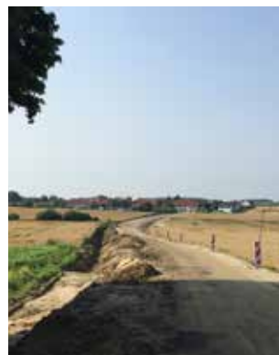
FS 3: Links: Während der Bauzeit
