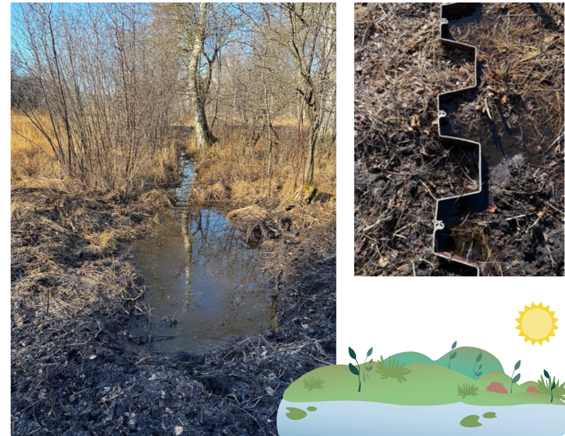
Der Graben links war fast schon verlandet. Durch die Spundwand (rechts) wird das Wasser am abfließen gehindert. Fünf Wochen nach dem Anstau bleibt immer mehr Wasser in der Fläche. Der Ausstoß von Treibhausgasen geht zurück. Moortypische Arten haben wieder einen Lebensraum. Nasser Moorboden stößt keine Treibhausgase mehr aus. Foto: Judith Jabs-Ingenhaag
